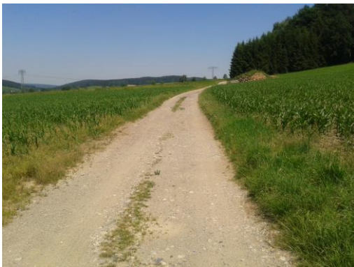
Bild 1: Blick vom Bauanfang
