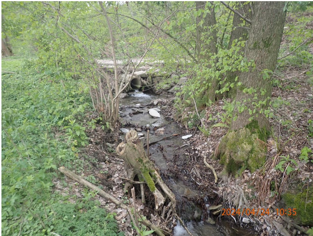
Abbildung 1-3 Ansicht Durchlass Unterstrom
