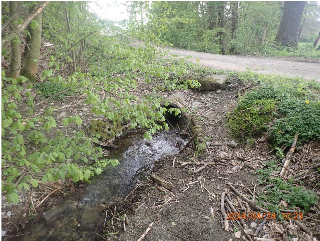
Abbildung 1-2 Ansicht Durchlass Oberstrom
