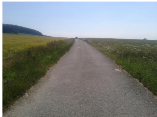
Bild 2: Blick vom Bauende
