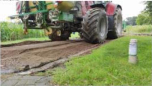
Nach dem Fräsen des Bodens wird das Additiv mit dem Zugbewässerung aufgespritzt.
